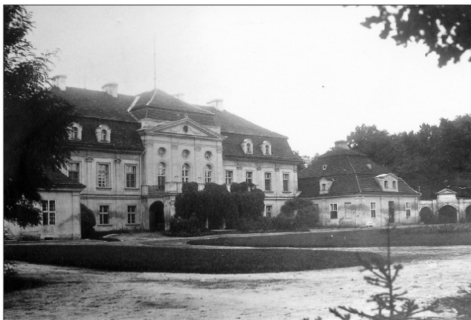
Pałac w Pępowie - Chocieszewicach ok. 1926r. 2 wysunięte pawilony w narożnikach to tzw. alkierze najprawdopodobniej obniżone w wyniku przebudowy w XVIII wieku.
